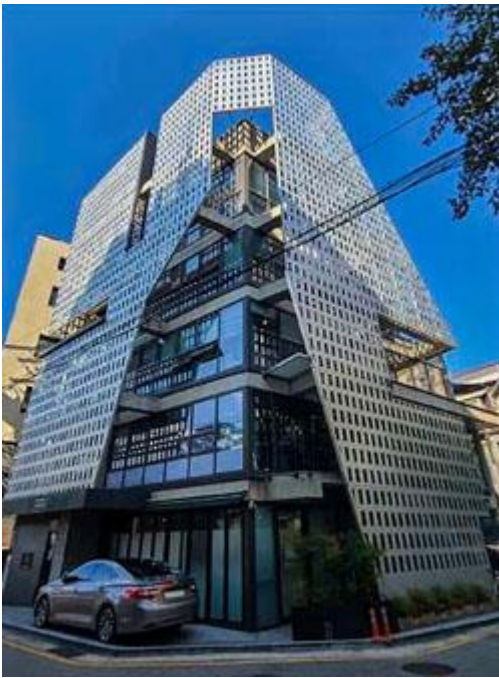
지하수 활용 수열냉난방시스템을 적용해 건축한 서초구 방배동 희오빌딩. 사진 옥수개발 제공
